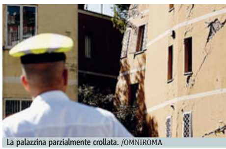
La palazzina parzialmente crollata. / OMNIROMA
