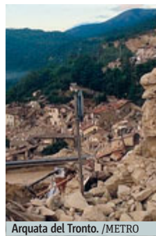
Arquata del Tronto. /METRO
