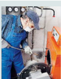
Controllo caldaie. /OLYCOM
