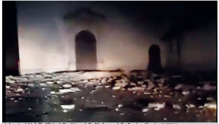
I danni subiti dall'edificio della chiesa della Madonna delle Grazie a Norcia. /METRO
