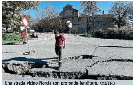
Una strada vicino Norcia con profonde fenditure. /METRO
