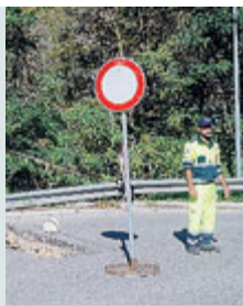
Lavori in corso. /LAPRESSE
