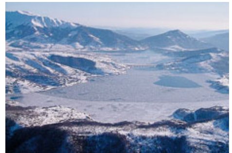
La diga di Campotosto. /METRO
