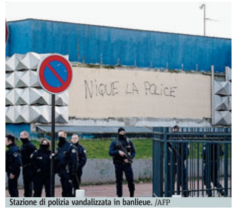
Stazione di polizia vandalizzata in banlieue. /AFP
