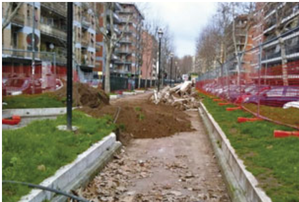
La pista ciclabile di viale Giulio Agricola occupata dal cantiere del parcheggio interrato
