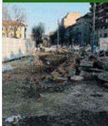
Gli scavi per la nuova stazione. FOTOGRAFIA
