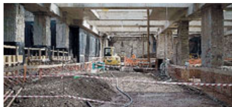
Il cantiere della Metro C.
