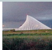
Lavori fermi per La Vela
