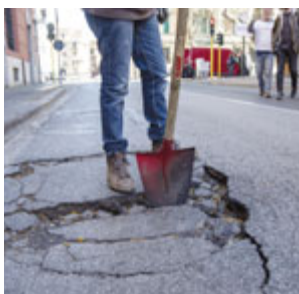
Via Nizza prima dell'intervento
