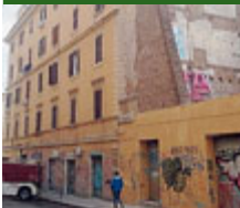
Il palazzo messo in sicurezza. METRO
