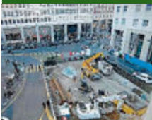
Il cantiere. FOTOGRAMMA
