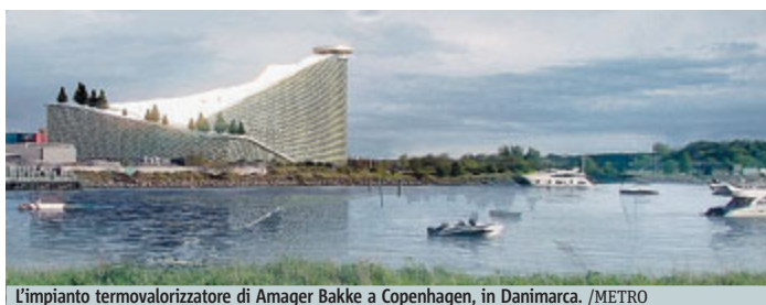
L'impianto termovalorizzatore di Amager Bakke a Copenhagen, in Danimarca. /METRO
