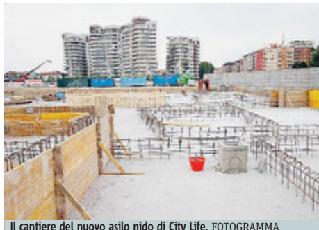
Il cantiere del nuovo asilo nido di City Life. FOTOGRAMMA
