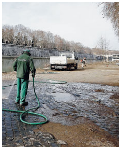
Primi lavori sulle banchine /LAPRESSE
