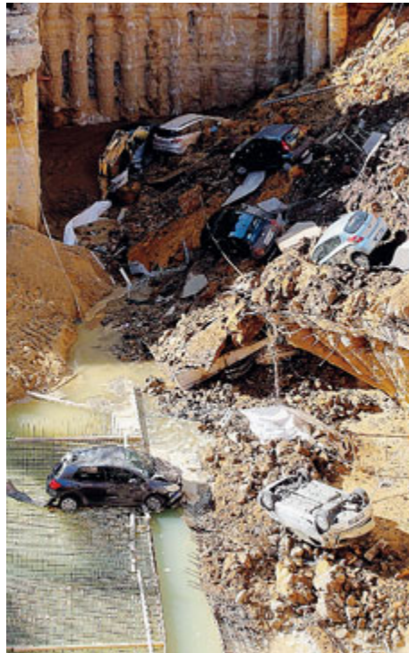
Il cantiere dopo il crollo di via Livio Andronico/ FOTOGRAMMA
