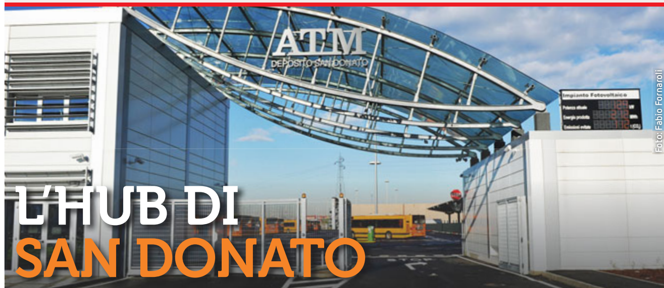
In foto: ingresso del deposito ATM di San Donato Milanese
