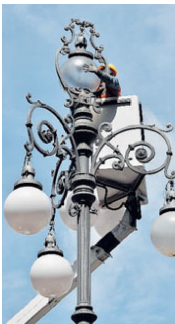
Interventi di efficienza energetica / FOTOGRAMMA
