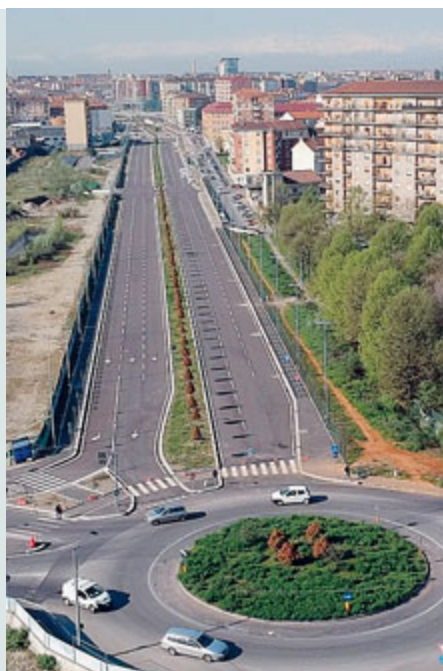
Il tratto di strada dopo i lavori. /CONTALDO
