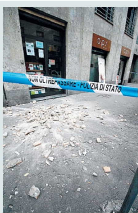
L'intonaco staccatosi dalla facciata del palazzo. FOTOGRAMMA
