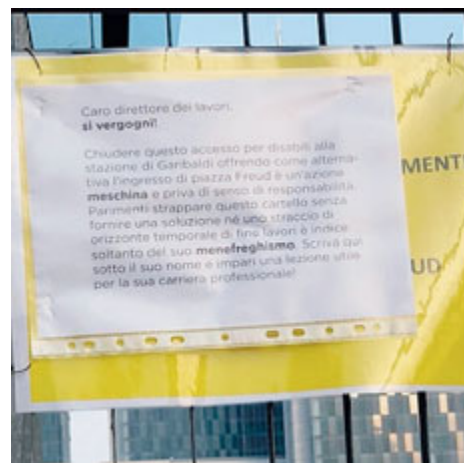
Un cartello appeso davanti alla rampa per disabili. METRO
