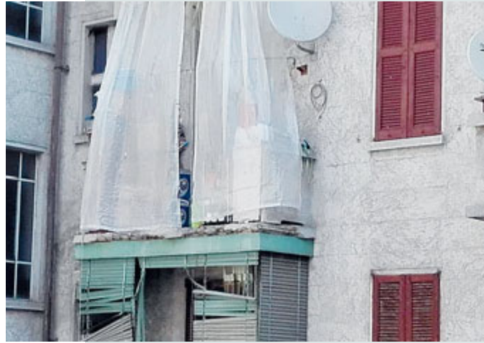
Il parapetto crollato in via dei Cinquecento. FOTO DI OSCAR STRANO
