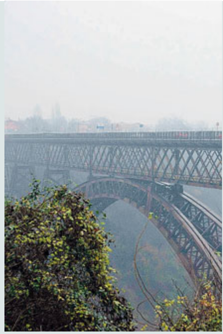
Il ponte di Paderno chiuso venerdì. /FOTOGRAMMA
