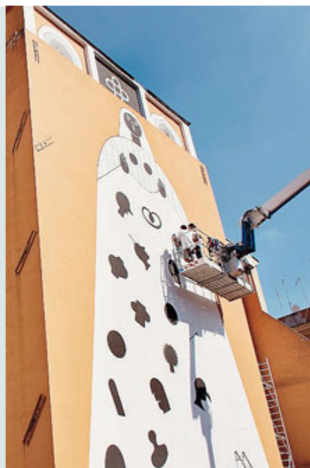
La facciata di Via dei Sabelli 36 /METRO
