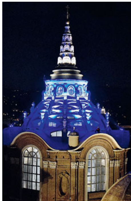
Fu chiusa l'11 aprile del 1997 per un incendio / FOTO CONTALDO
