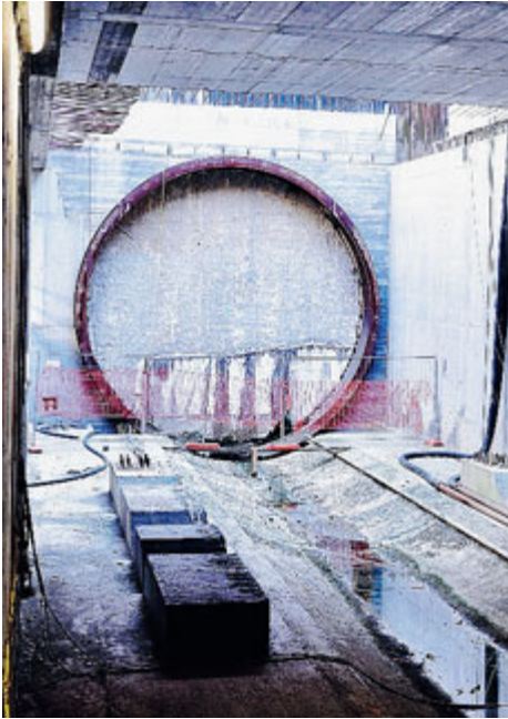
Il cantiere della M4 in piazzale Frattini. /FOTOGRAMMA
