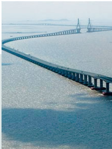
Il ponte tra Hong Kong Macao e Zhuhai. /METRO
