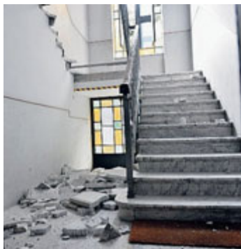
La rampa di scale crollata ieri pomeriggio. /CONTALDO
