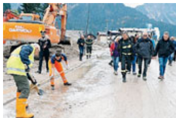
Lavori di ripristino nel bellunese. /LAPRESSE
