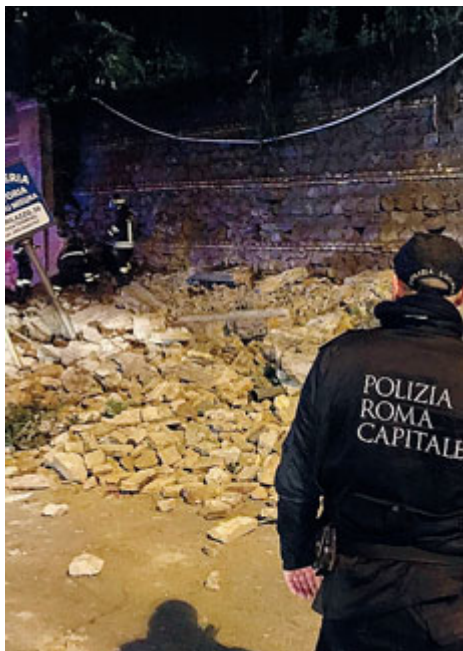
Il muro crollato /NOVA
