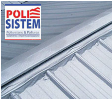
LA POLIUREA È EFFICACE PER IMPERMEABILIZZARE
