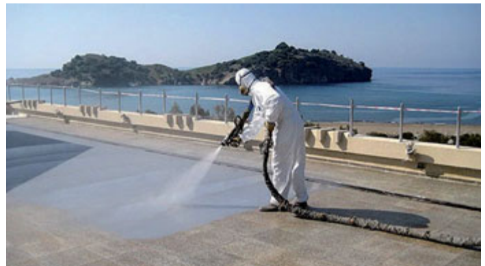
LE SUPERFICI SOGGETTE A CONTINUI EVENTI ATMOSFERICI POSSONO ESSERE TRATTATE CON QUESTA TECNICA
