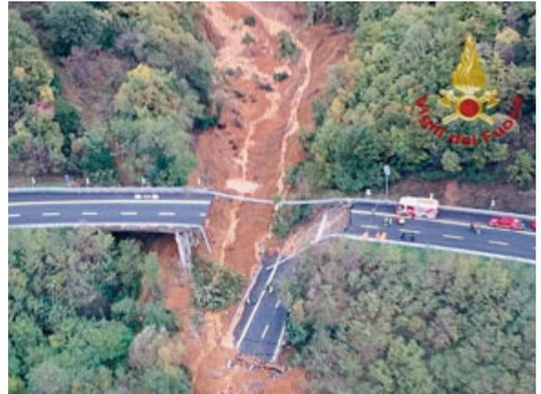
una pila del viadotto "Madonna del Monte" causando il crollo di circa 20 metri di impalcato», ha precisato Autostrada dei Fiori. Non si segnalano feriti, ma è stata verificata la possibile presenza sotto i de-
