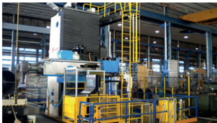
ESEMPIO DI UN ADEGUAMENTO DI UN'ALESATRICE, UNA MACCHINA FORATRICE ESTREMAMENTE PRECISA
