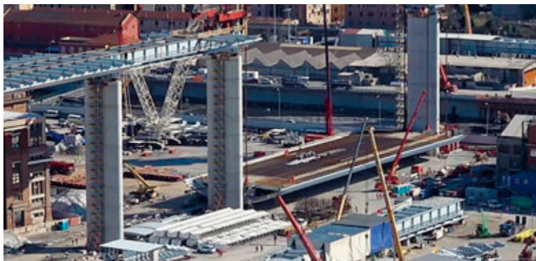
L'impalcato durante le prime fasi del sollevamento. /METRO
