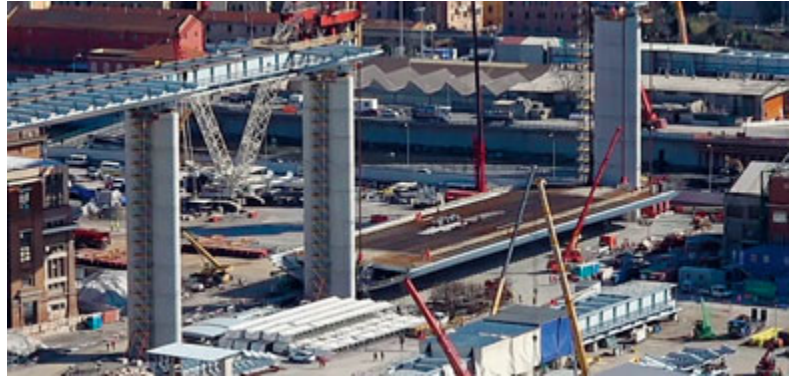
L'impalcato durante le prime fasi del sollevamento. /METRO
