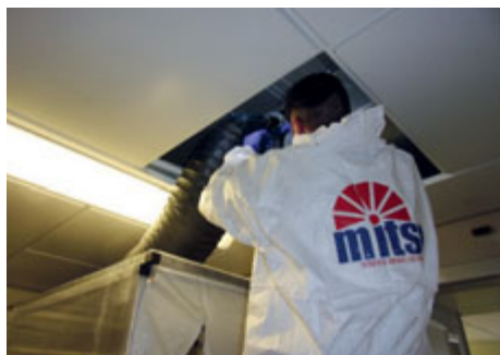
I PROFESSIONISTI DELL'AZIENDA SANIFICANO L'IMPIANTO
