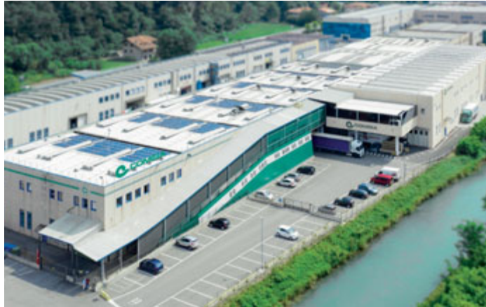
LA SEDE PRINCIPALE A PISOGNE, IN PROVINCIA DI BRESCIA
