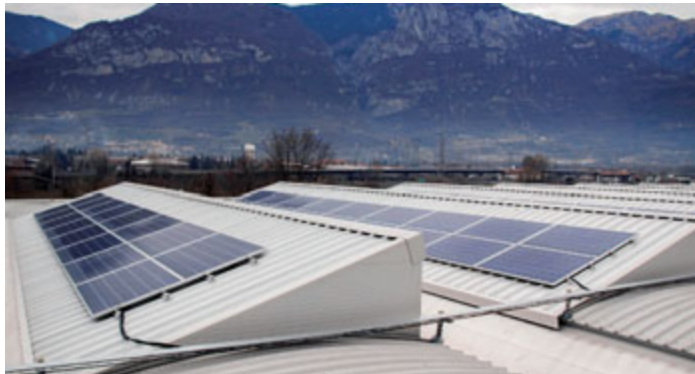
L'AZIENDA HA QUASI RAGGIUNTO L'AUTOSUFFICIENZA ENERGETICA GRAZIE ALL'IMPIANTO FOTOVOLTAICO
