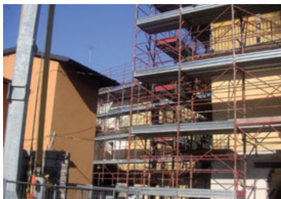
OGNI CANTIERE DEVE SEGUIRE REGOLE E ADEMPIMENTI
