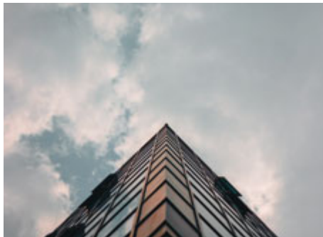
IL FACILITY MANAGEMENT VALORIZZA OGNI TIPO DI STRUTTURA
