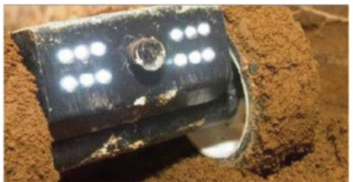
NEGLI ANNI SCORSI NON SI DAVA PESO ALLA PULIZIA DEI CONDOTTI AERALIUCI
