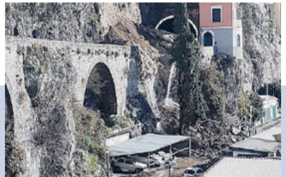
La frana che ha interrotto la statale Amalfitana. /METRO
