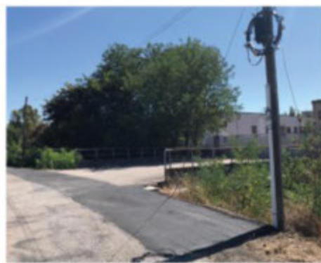
L'AZIENDA INSTALLA FISICAMENTE LA FIBRA
