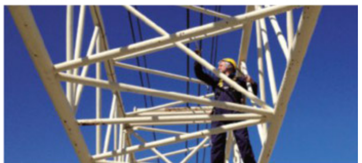
LA VERIFICA IN QUOTA DI UNA GRU TRALICCIA
