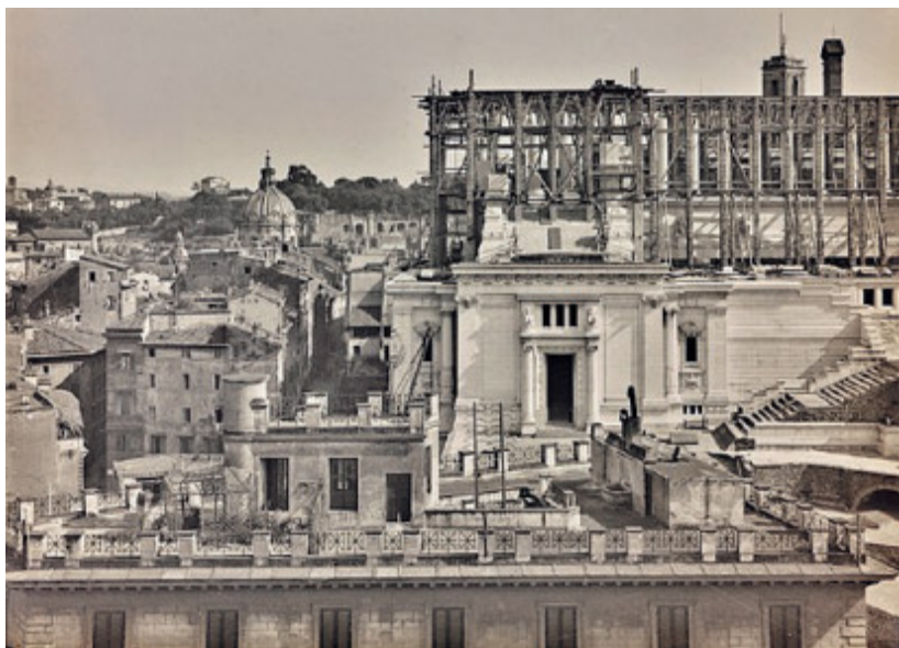
L'Altare della Patria in costruzione, 1935 circa, Gustave Eugène Chauffourier. (Tutte le immagini sono dell'Archivio Alinari)
