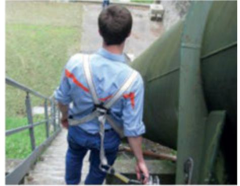
LINEE VITA LUNGO CONDOTTE FORZATE DI IMPIANTI IDROELETTRICI
