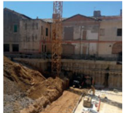
LO SCAVO PARK INTERRATO EX INTENDENZA FINANZE A PADOVA
