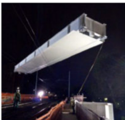
I LAVORI ALLA FERMATA TIBALDI A MILANO
