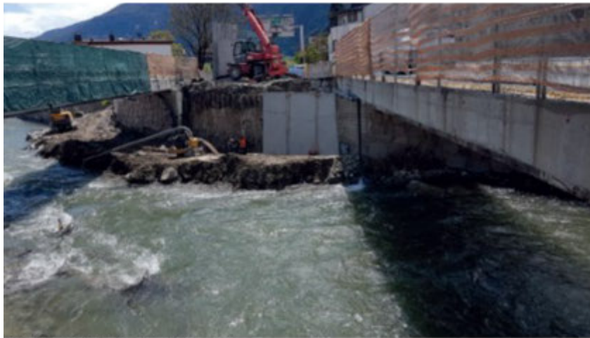
IL CANTIERE DEL NUOVO PONTE HOFER A VIPITENO (BZ)
