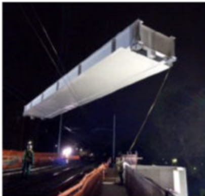
I LAVORI ALLA FERMATA TIBALDI A MILANO
